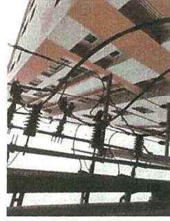
อุปกรณ์ป้องกันฟ้าผ่า Lightning Arrester
