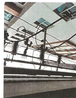
ตู้ควบคุมไฟฟ้า ตู้ควบคุมสูง (Drop Out Fuse)
